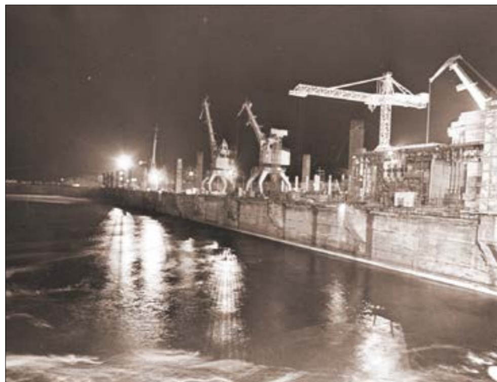
Общий вид строительства Нижнекамской ГЭС. 1979 год.
